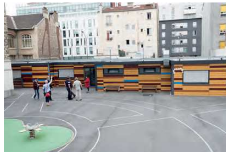
École Victor-Hugo, visite de travaux des préfabriqués de maternelle avant la rentrée.
