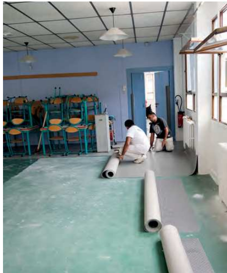
Travaux de rénovation à Bachelet.
