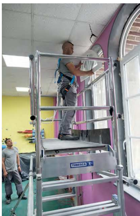
Changement de fenêtres à Anatole-France.
